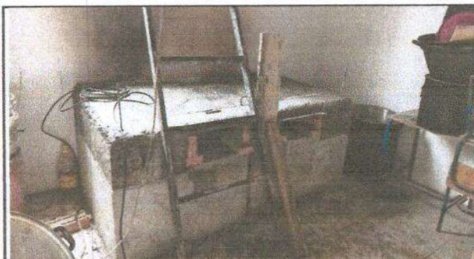
Foto 3: Se visualiza el avance del pegado de piso cerámico en la cocina, Módulo I
