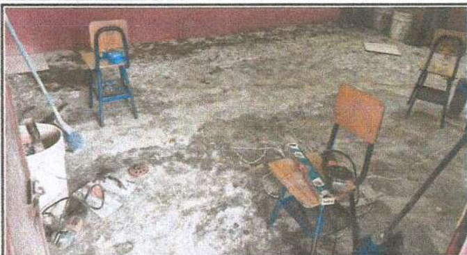
Foto 1: se Visualiza el pegado del piso cerámico en el aula, Módulo II
