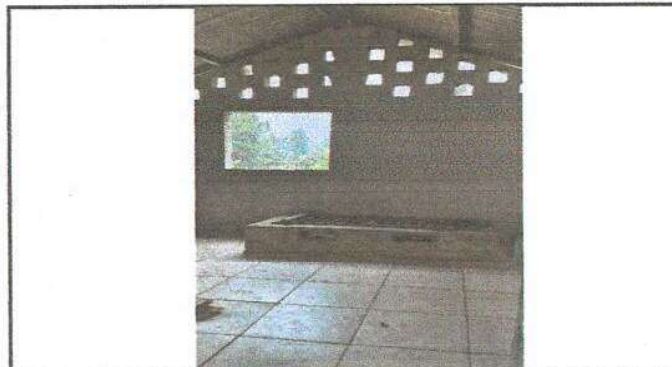
Foto 4: Se visualiza el avance del repello en la pared de la cocina, Módulo I
