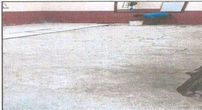
Foto 2: Se visualiza el avance del pegado de piso cerámico, Módulo I
